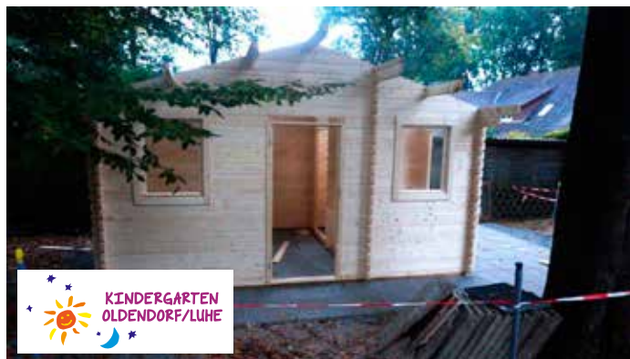
Holzstätte im Bau
