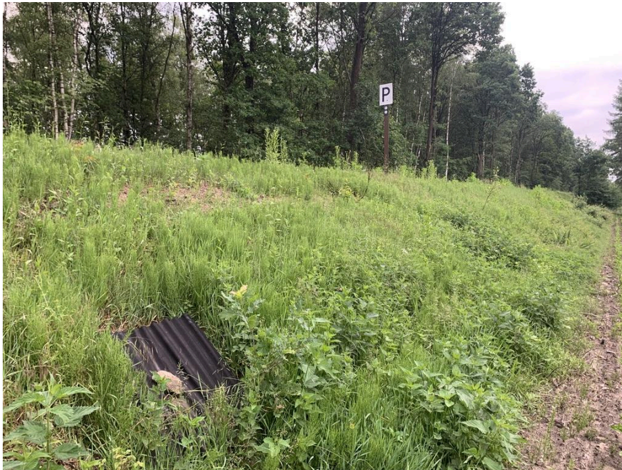
Abb. 9: Bahndamm nördlich Teilfläche II
