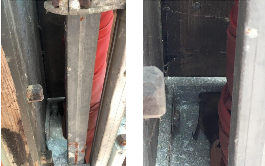
Abbildung 66: Fledermaus im Zwischenquartier am Kioskgebäude, 06.04.2020. (linke Aufnahme: Übersicht, rechte Aufnahme: Ausschnittsvergrößerung)
