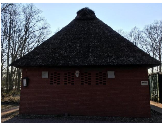
Abbildung 43: Mauerlöcher am Kioskgebäude – Brutplatz der nachgewiesenen Bachstelze
