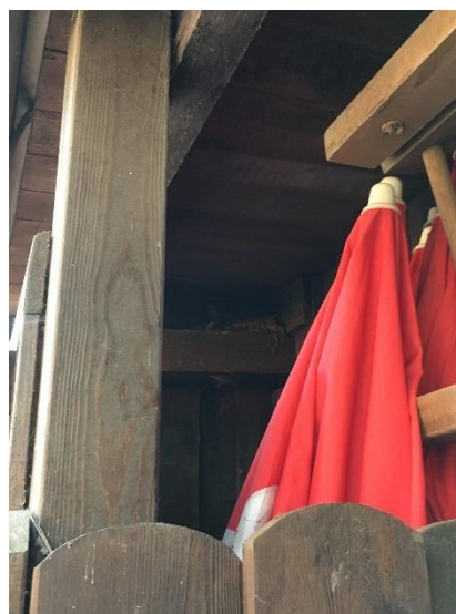
Abbildung 54: Verlassenes Vogelnest an einem der Holzschuppen
