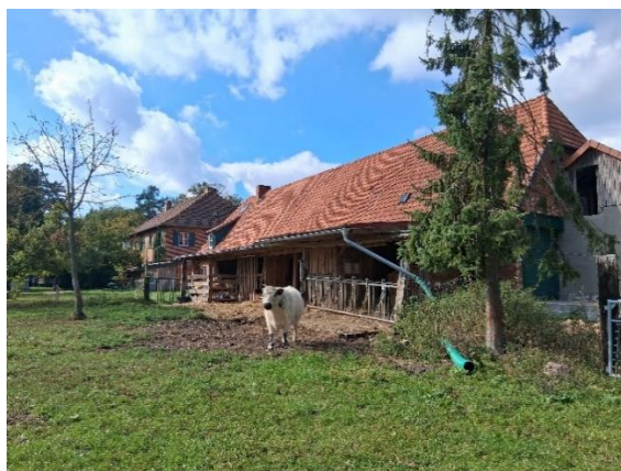
Abb. 10: Blick Richtung Nordwesten, hinter dem Wohngebäude verläuft die Celler Landstraße. Von hier an weiter Richtung Süden erstreckt sich das Grünland, wo zukünftig Wohnbebauung ermöglicht werden soll.
