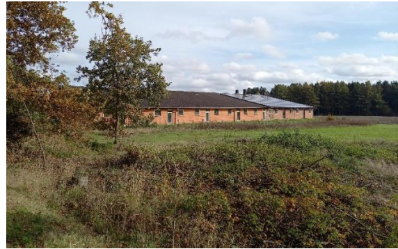
Blick auf die Westseite des Plangebiets mit vorhandenem Stallgebäude
