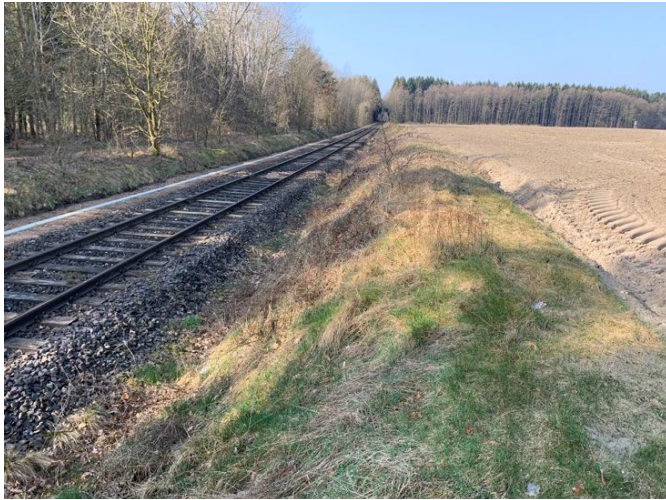
Abb. 5: Bahndamm von Osten
